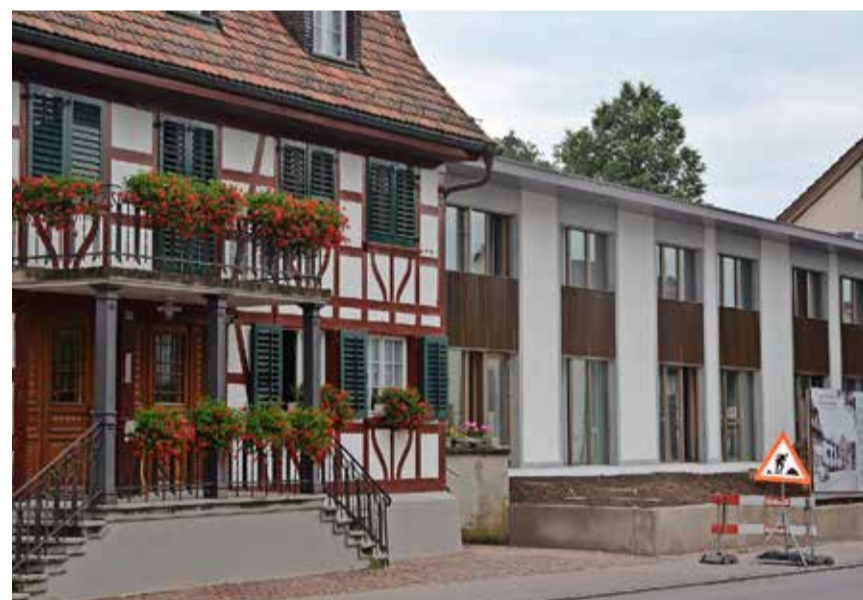
Alt und Neu verbinden sich beim Alters- und Pflegezentrum Stammertal harmonisch – aber noch steht die Sanierung des Altbaus bevor.
